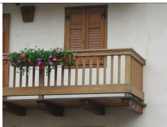
Balcone con parapetto in legno a ritti verticali e struttura e impalcato in un recente intervento
